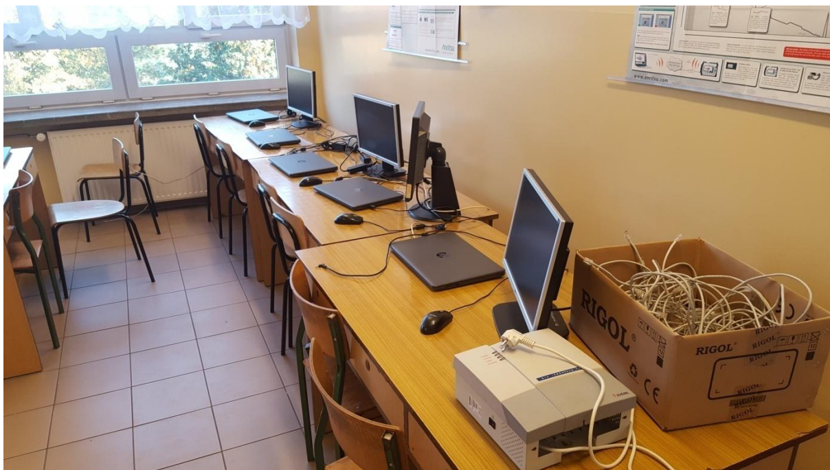
Pracownia teleinformatyczna sieci i urządzeń
